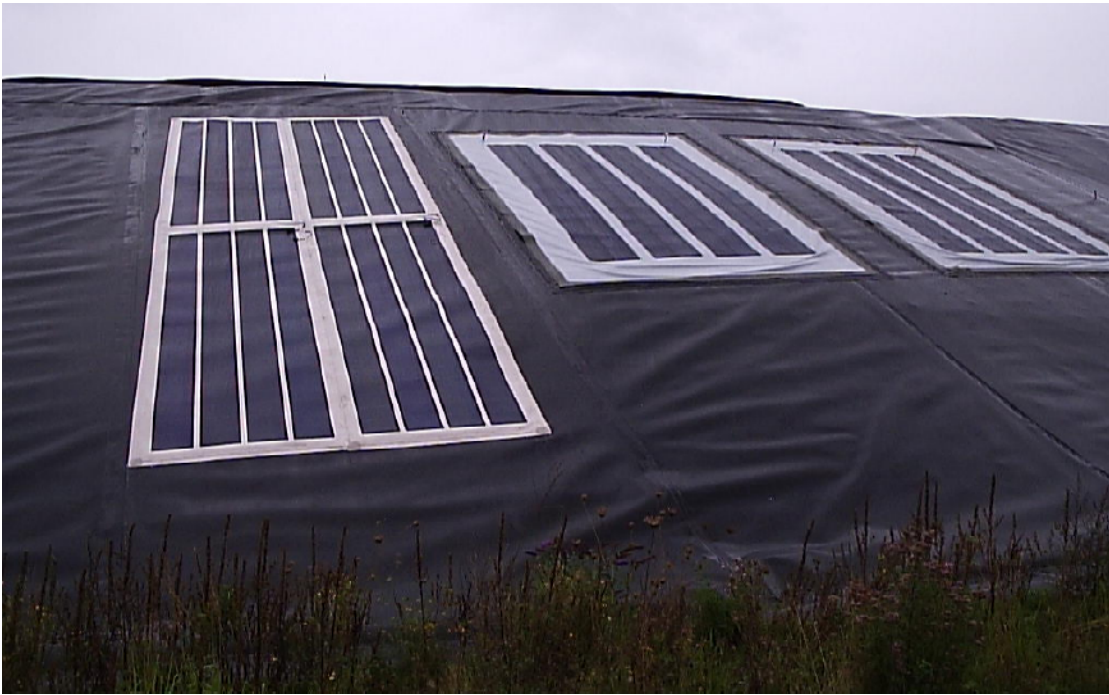
Abb. 5: Einbau der ersten Versuchsfelder
